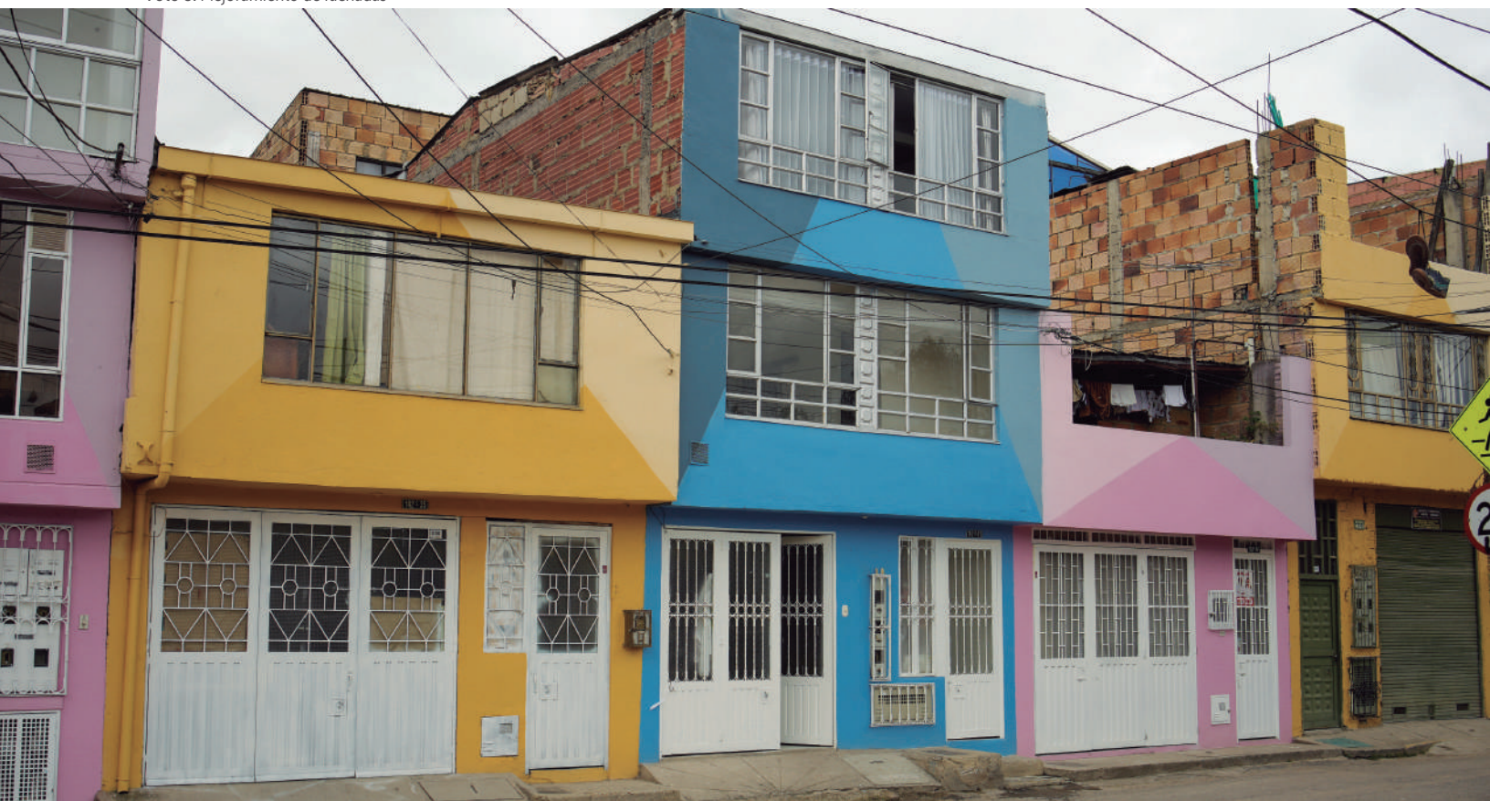
Foto 8. Mejoramiento de fachadas
