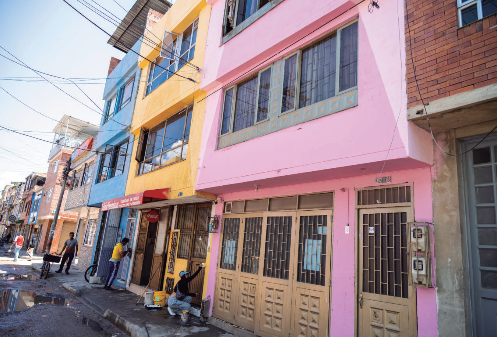
Foto 7. Mejoramiento de fachadas
