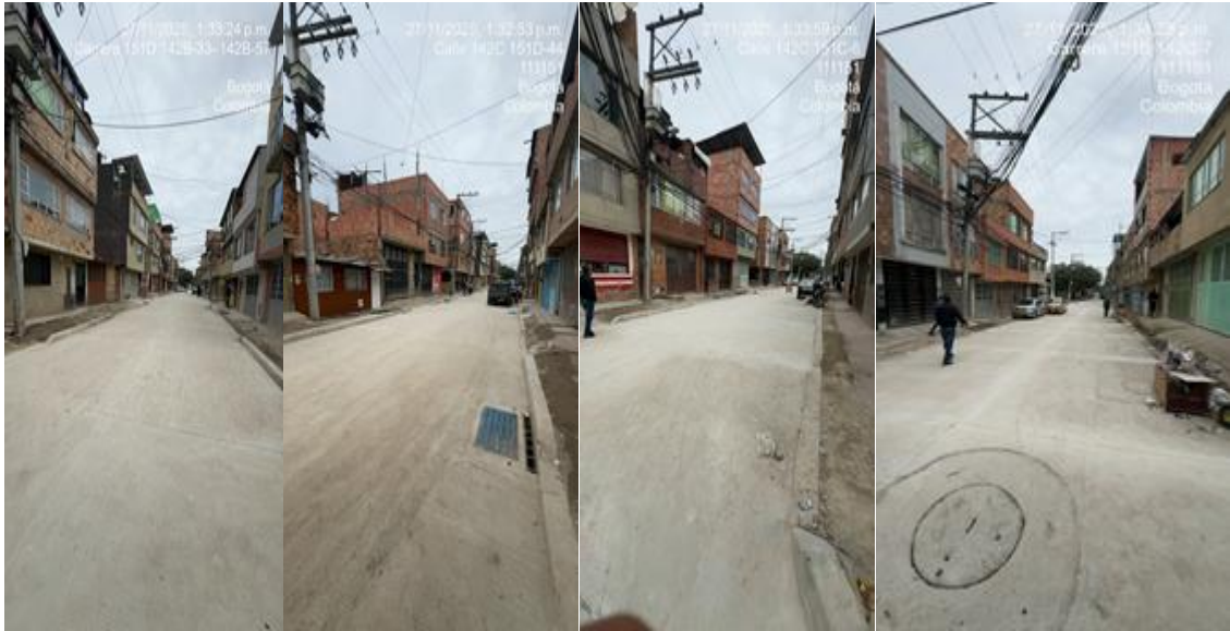
Ilustración 4. Construcción calzadas Barrio Bilbao
