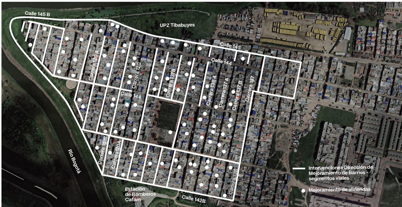
Aerofotografía con los procesos de mejoramiento integral realizados en Bilbao. Fuente: Caja de la Vivienda Popular, 2026.
